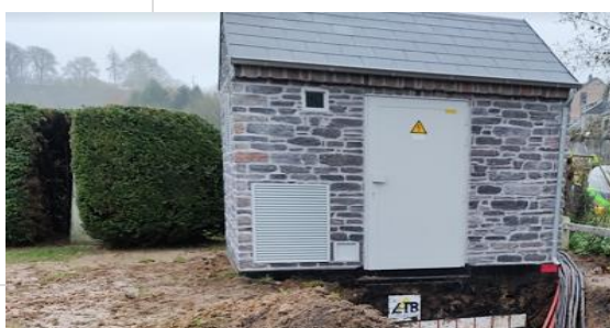
Après les travaux
