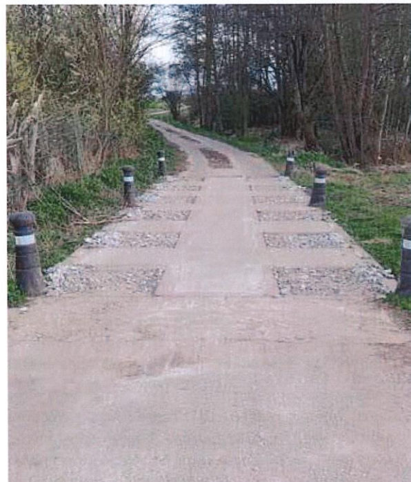
Ecluse empierrée à Eghezée
