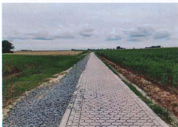
Chemin induré de largeur restreinte à Walhain
